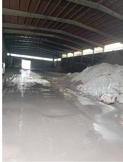
废气治理设施现场图片
