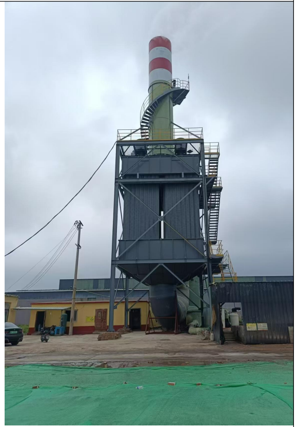
隧道窑焙烧废气对应的 SNCR 脱硝+双碱法脱硫+湿电除尘系统+40 米高排气筒
