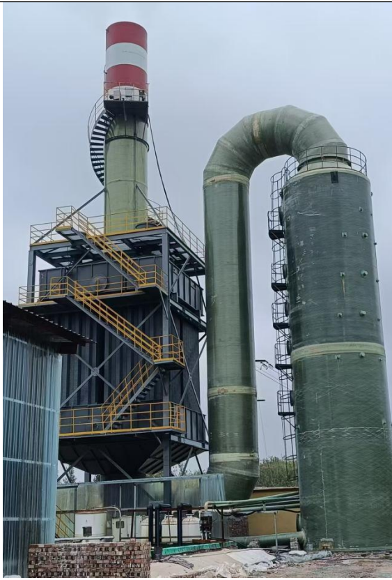
隧道窑焙烧废气对应的 SNCR 脱硝+双碱法脱硫+湿电除尘系统+40 米高排气筒
