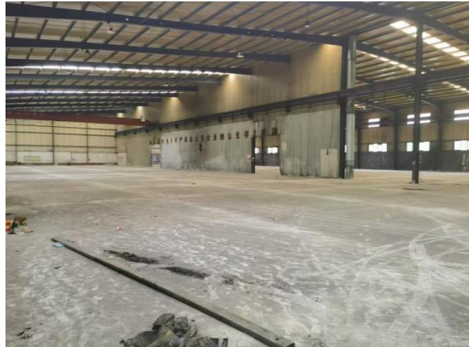
车间内部现状
